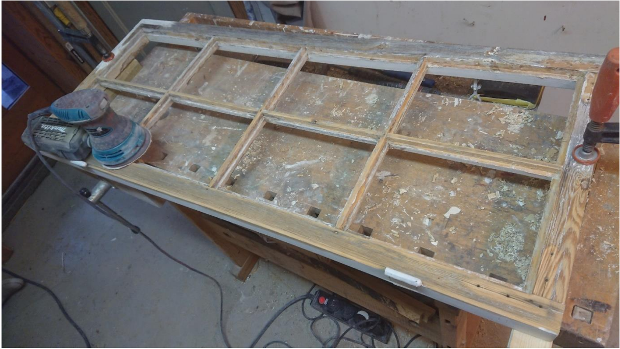
Sliping av treverk
