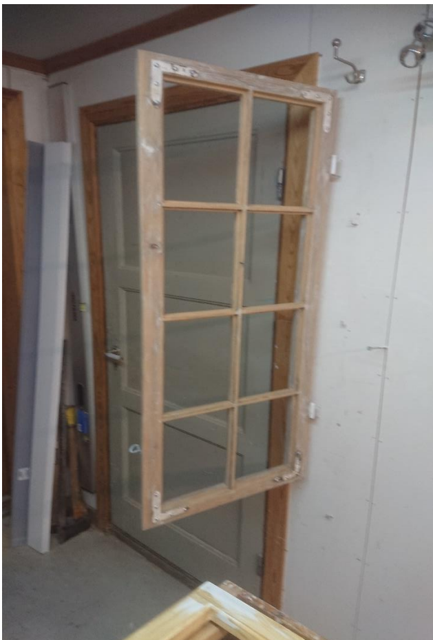
Grunning med Butinox grunning (vannbasert) Metall ble grunnet med Owatrol
