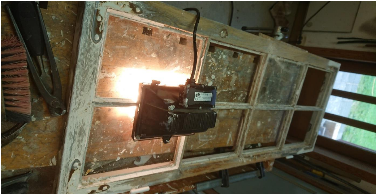
Fjerning av fast kitt ved hjelp av varmelampe
